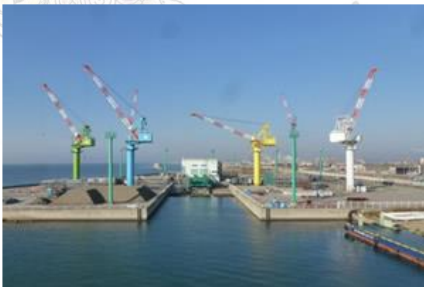
平台滑車併用沉箱製作場
